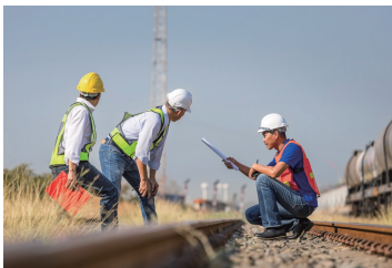
作業手順と現場状況を映像で記録
