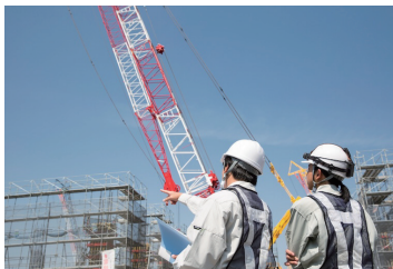
施工中の状況をそのままエビデンス化
